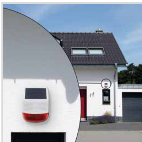
Abb. B Sirene an einer Hauswand montieren.
