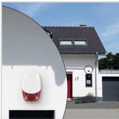
Abb. B Sirene an einer Hauswand montieren.
